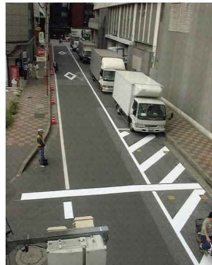
図表 柏駅東口地区の路上荷さばき駐車施設（荷さばきスペース）
