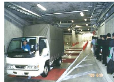
〈貨物車が走行できる走行路(トンネル)〉
