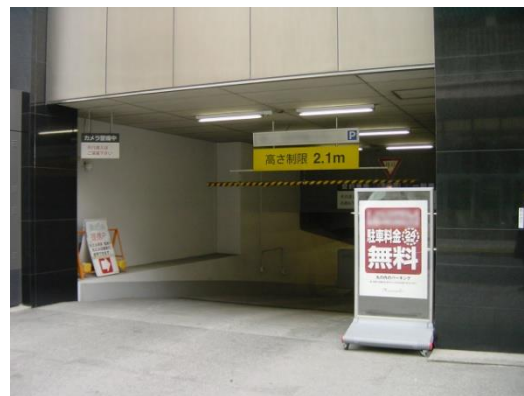
図 3-11 高さが十分に確保できていないビルの事例 (高さ 2.1m では貨物車利用に十分ではない)
