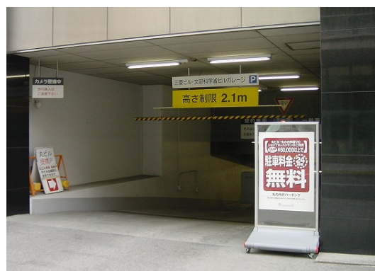
図 2-4 丸の内地区内で高さが確保できていないビルの事例(高さ 2.1m では貨物車利用に十分ではない)
